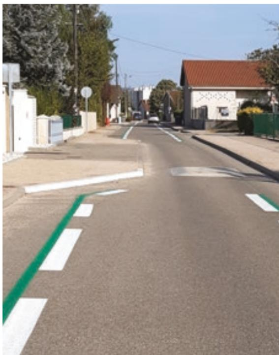
Les rues du Val de Richagnon, des Lazaristes et des Cadalles ont été aménagées avec la mise en place d'une CVCB (chaussée à voie centrale banalisée). La CVCB permet de prendre en compte les cyclistes dans les cas rares où les contraintes géométriques et circulatoires rendent impossible le recours aux aménagements cyclables traditionnels.
