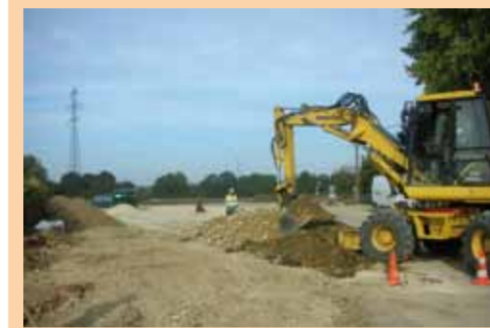
Chemin des Cadalles, afin de sécuriser la circulation, la chaussée sera rétrécie par endroits et des trottoirs seront créés.
