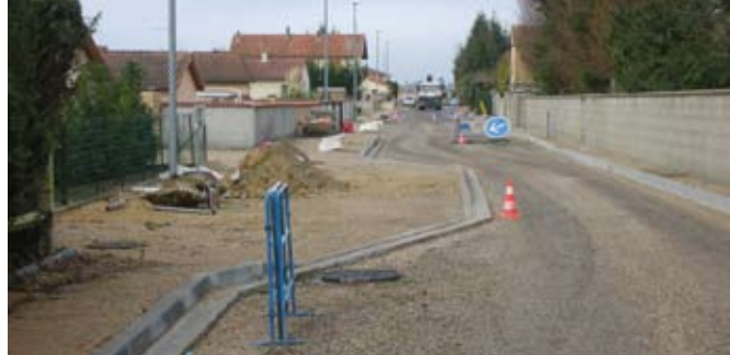
Des trottoirs ont été aménagés rue Pascal.
