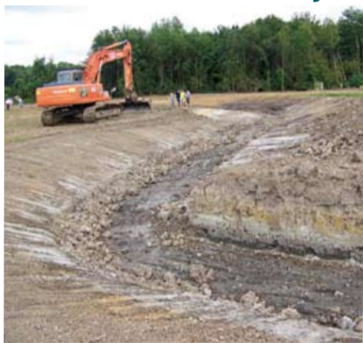
Première étape des travaux de terrassement : matérialiser le tracé du futur cours d'eau à l'aide d'un bulldozer guidé par GPS. Les pelles mécaniques ont ensuite commencé à creuser le nouveau lit de la Veyle, en partant de l'aval du chantier.
